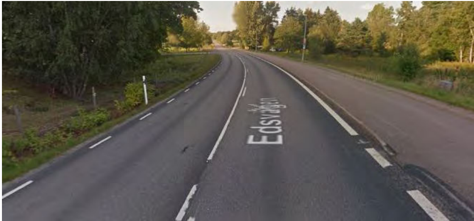
Figur 3-5 Väg 2025 söderut vid anslutningsväg alternativ Brätte
