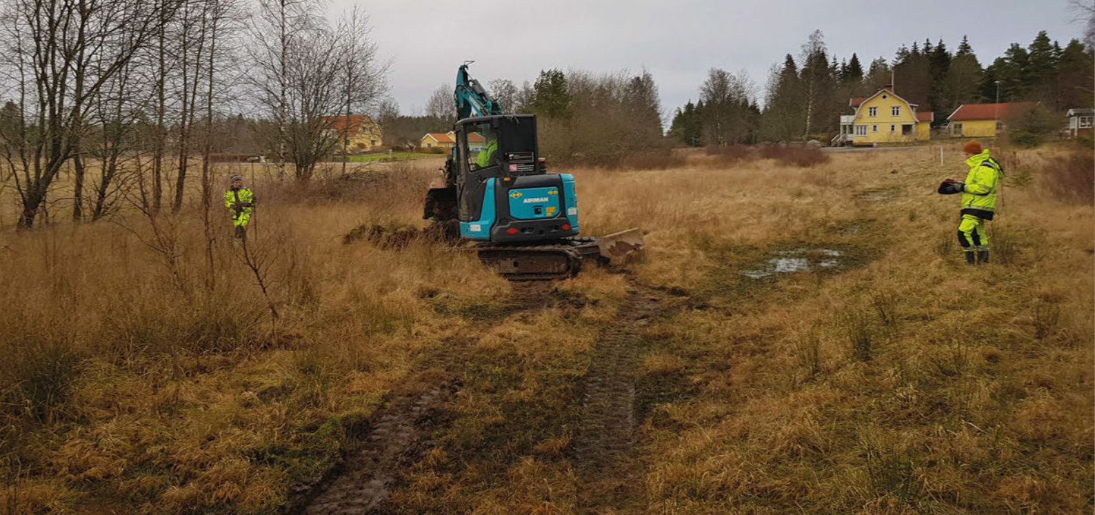
Figur 3. Arbetsbild vid schakt S1075. Foto: Mats Hellgren
